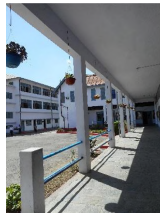
Fig.: RCC Column
