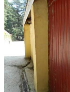
Fig.: RCC Column
