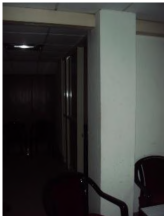
Fig.: RCC Column
