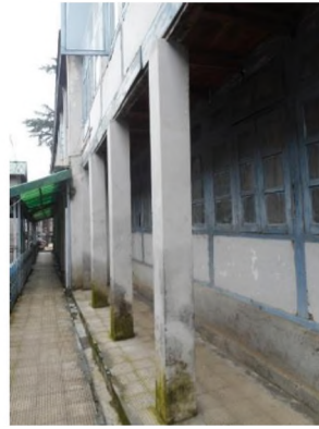
Fig.: RCC Column
