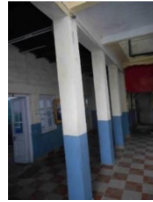
Fig.: RCC Column
