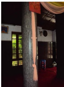
Fig.: 9(RCC Column)
