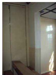
Fig.: RCC Beam
