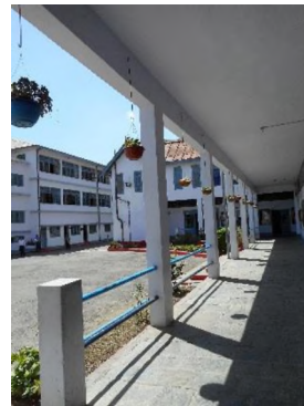
Fig.: RCC Column
