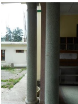
Fig: RCC Column
