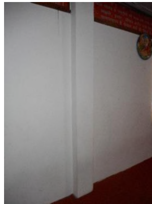
Fig.: RCC Column
