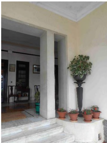
Fig.: RCC Column
