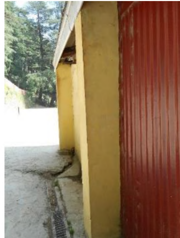
Fig.: RCC Column
